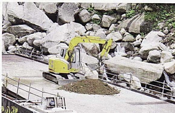
(鉄骨製の仮歩道、比較ユンボ6t)
