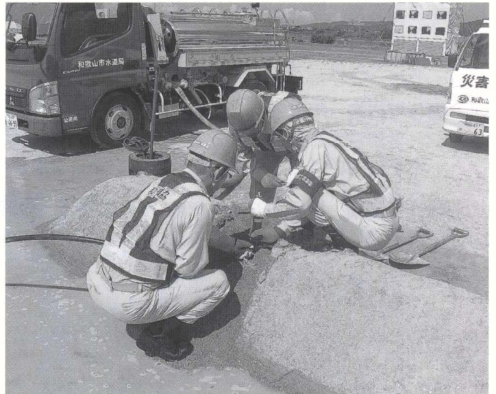
④ 仮設給水柱設置のための穿孔工事
