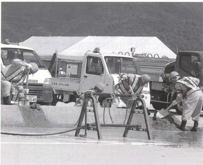
⑤ 水道管の復旧と仮設給水柱の設置
