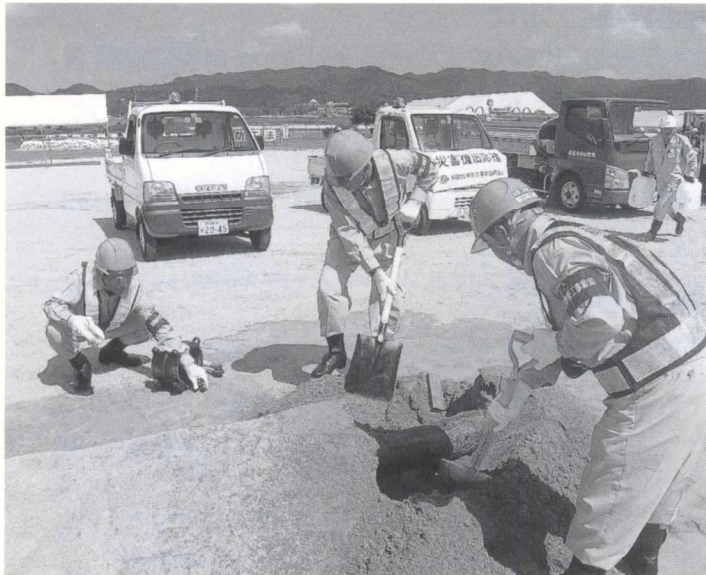
③ 配水管復旧工事
